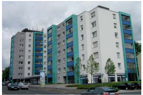
Hohemarkstr. 73-73c: In diesem Gebäude der OWG wurde das Energiesparsystem Ecotech von techem installiert. Die Erfahrungen damit sind sehr gut.
